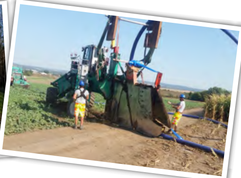
Pluhování potrubí PE DN 150
