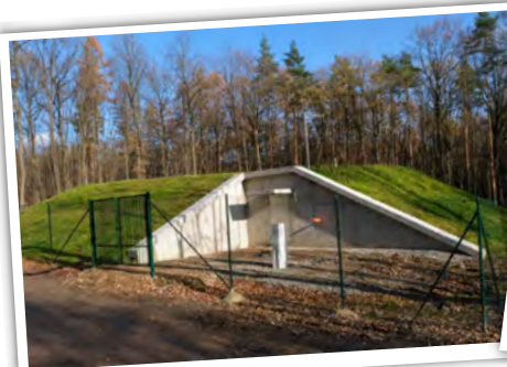
Vodojem Pozoříce III
