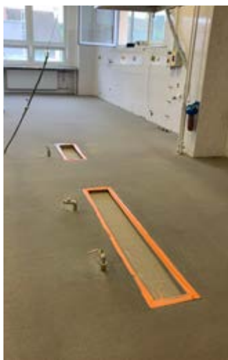
Rekonstrukce podlahy v kuchyni
